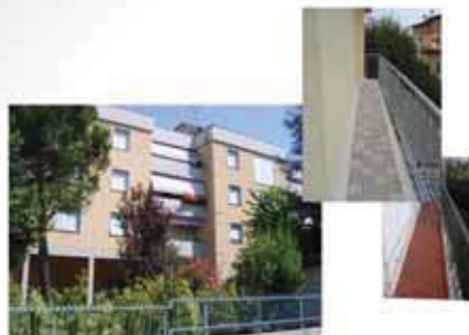
Rifacimento esterni condomini
